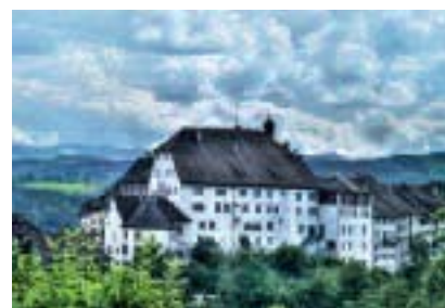
Gesamtansicht des Hofes zu Wil: Die Sanierungsarbeiten sind ein Projekt für mehrere Generationen.
