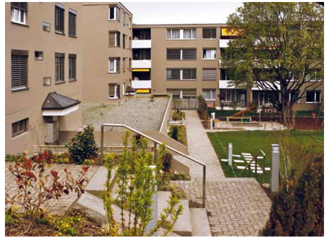
Erneuerung Siedlung Haupt, Dänikon
