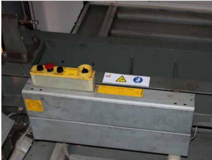
Einfach, aber sehr effektiv. Der Kleber, der dem Servicetechniker oder Reparaturmann signalisiert, dass auf diesem Kabinendach erhöhte Absturzgefahr besteht.
